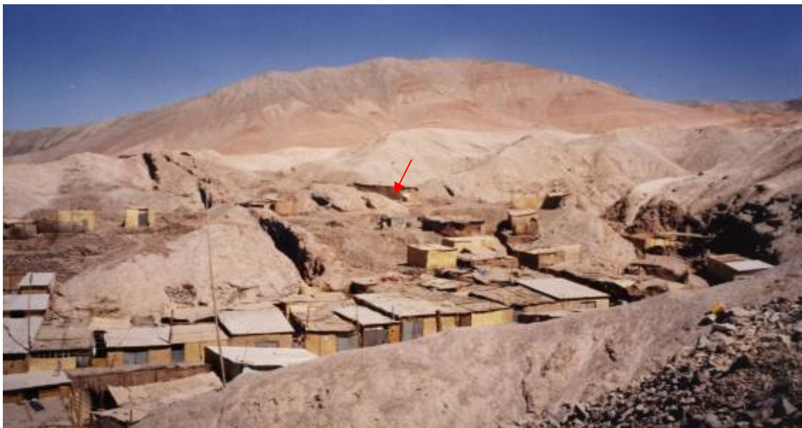
Foto 02. Vista panorámica de la Ubicación de la Retorta Comunal
