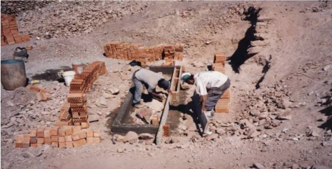
Foto 03 Inicio de Construcción de la Retorta Comunal.
