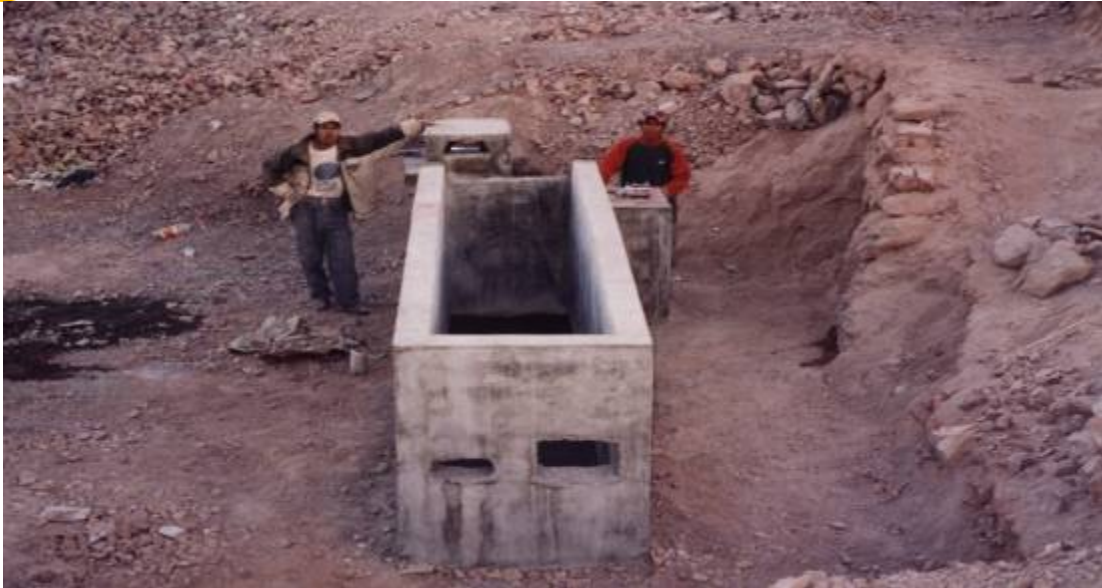
Foto 05. Retorta terminada parcialmente, listo para la colocación definitiva de tubos y accesorios.
