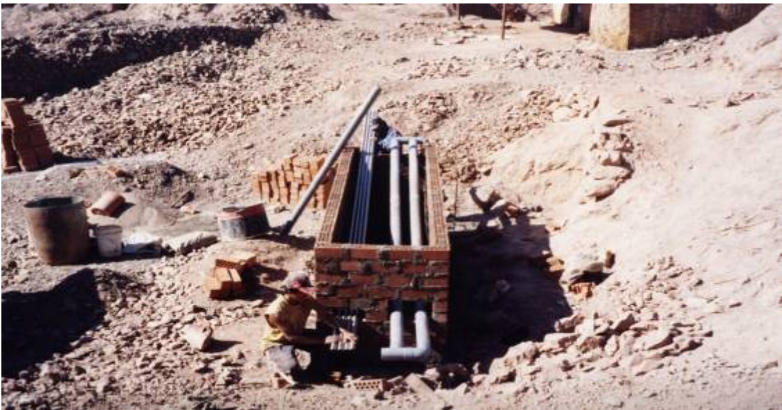
Foto 04 Presentación de Tuberías, para obtener las medidas exactas para la colocación de los accesorios de la Retorta Comunal.
