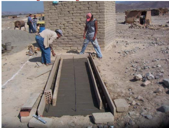
Foto 01. Início de la construcción de bases de la retorta.
