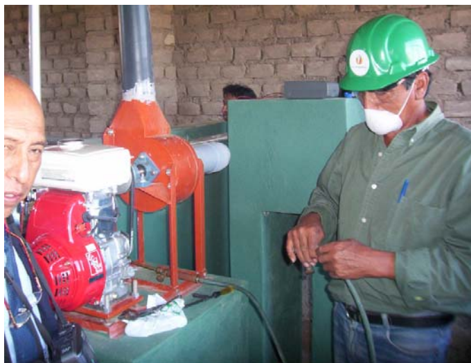
Foto 05. Verificación del equipo, seguimiento de funcionamiento
