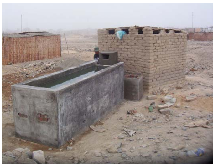
Foto 02. Culminación preliminar de la retorta, llenado de agua para un buen fraguado y detección de posibles fallas.
