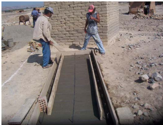
Foto 04 Inicio de la construcción de la Retorta
