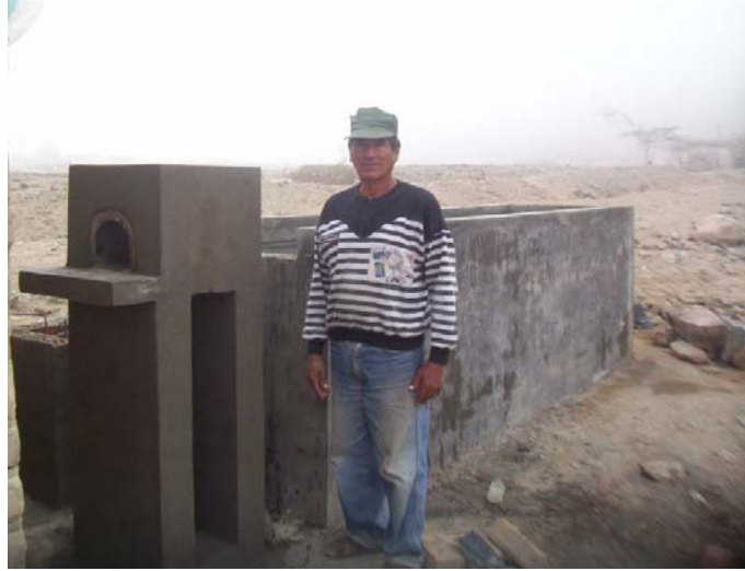
Foto 06 Retorta, quedando listo para la colocación de tuberías y equipos.
