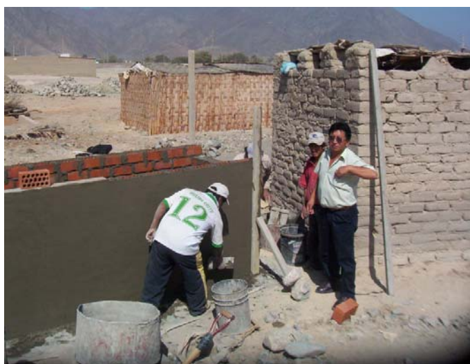
Foto 05 Construcción de la Retorta
