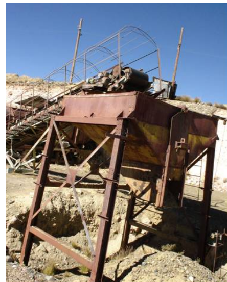
Figura Nro. 18b: Tolva de recepción para el material grueso del Trommel Nro 1.
