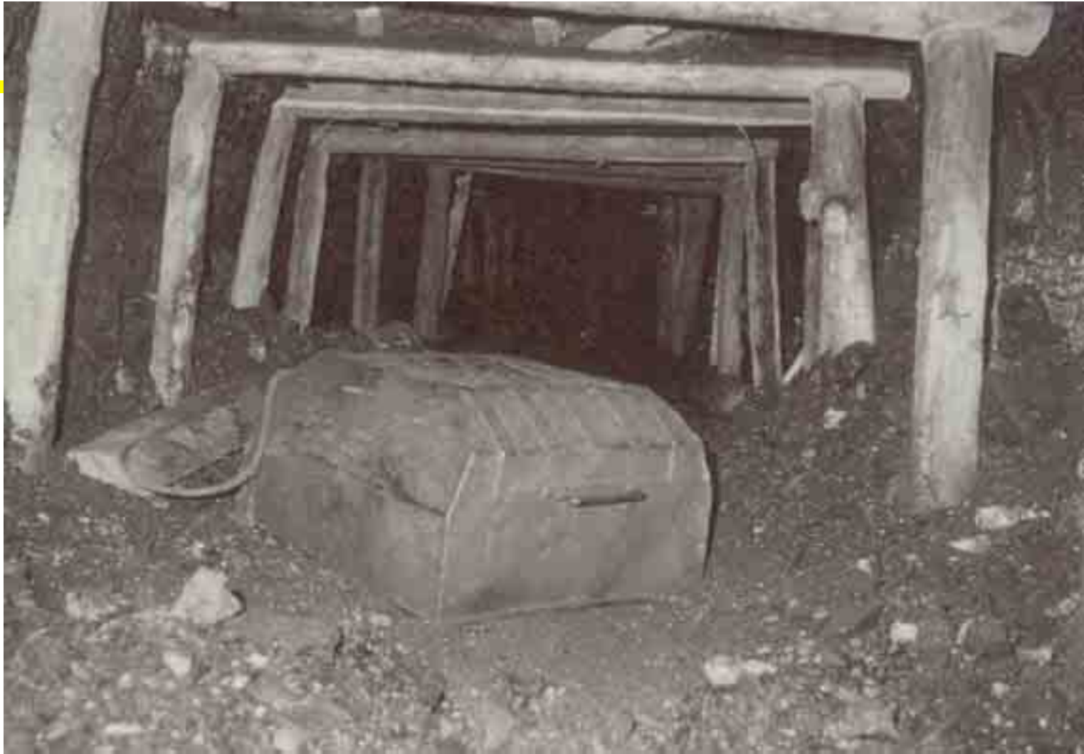
Trineo de arrastre para el transporte en explotación en una estratificación semiempinada
