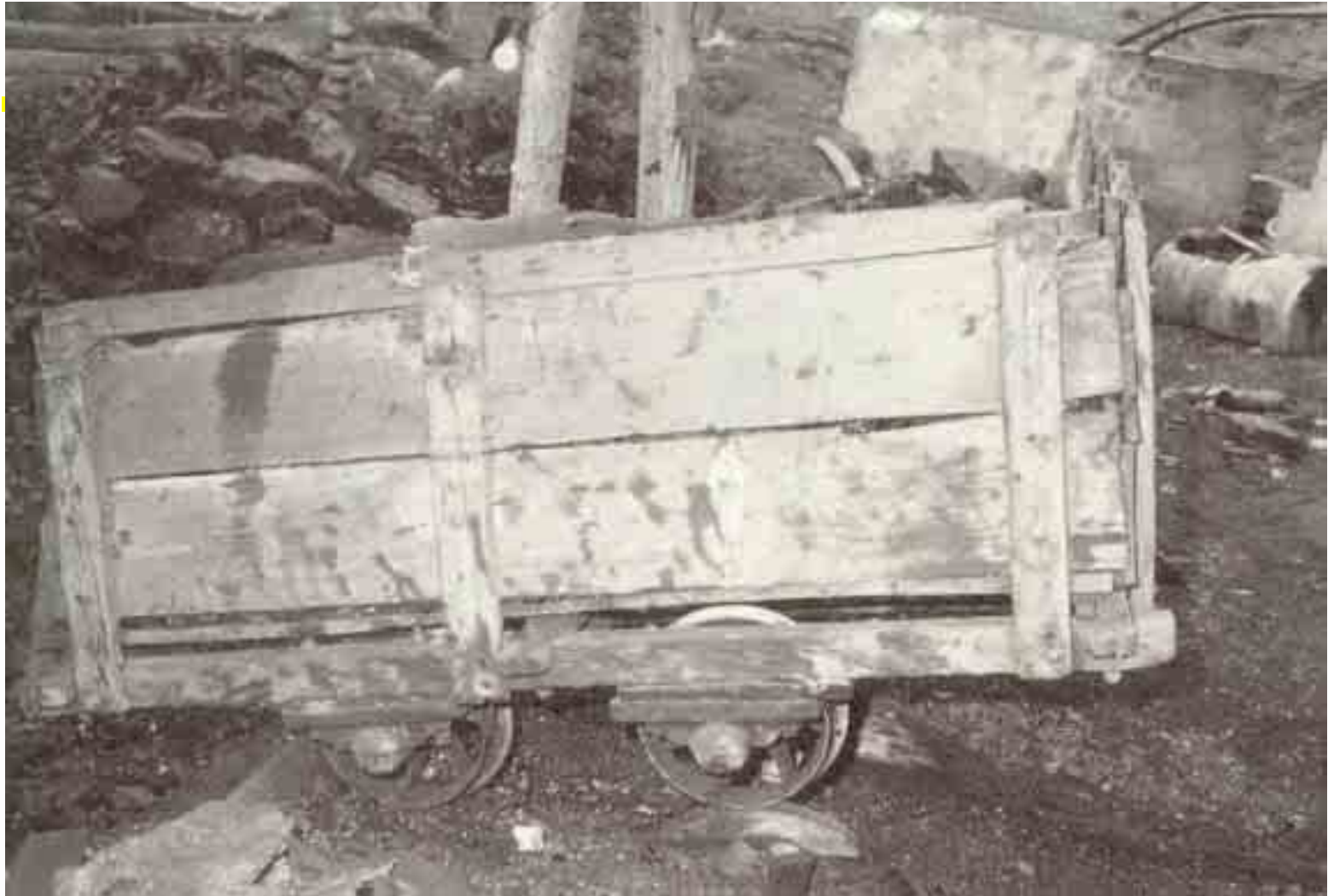
Vagón de madera con compuerta frontal. Instalación de volteo en superficie que facilita el vaciado del vagón.
