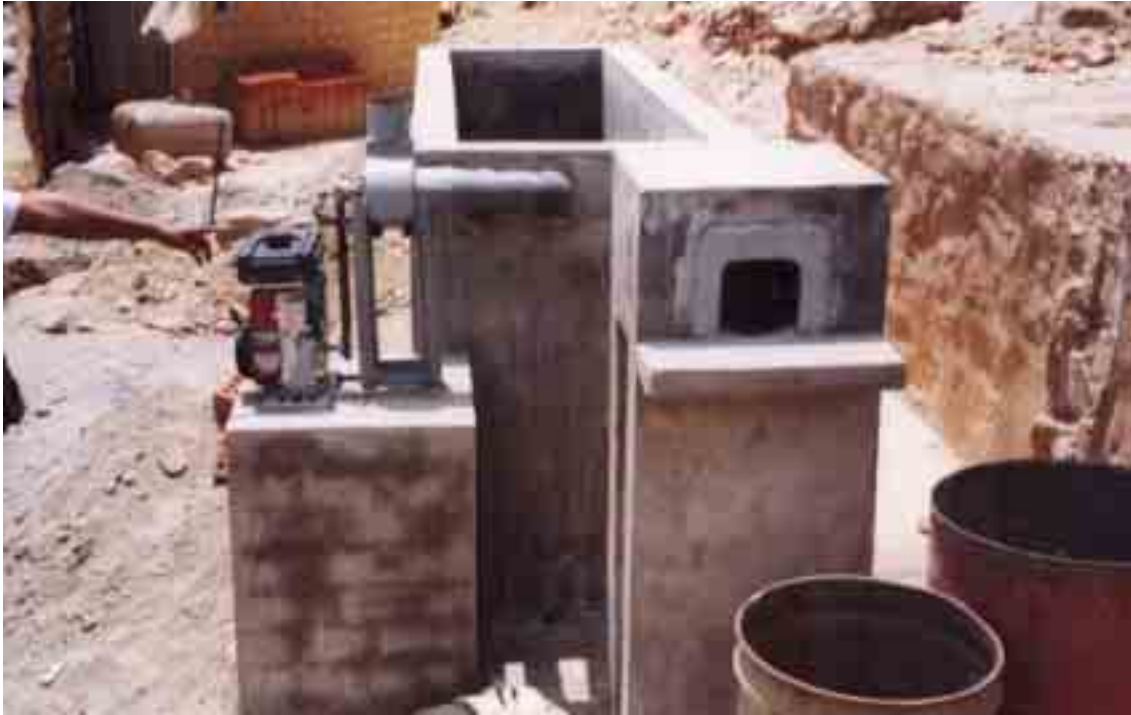
Foto 13: Instalación y presentación de motor y ventilador de la retorta comunal.
