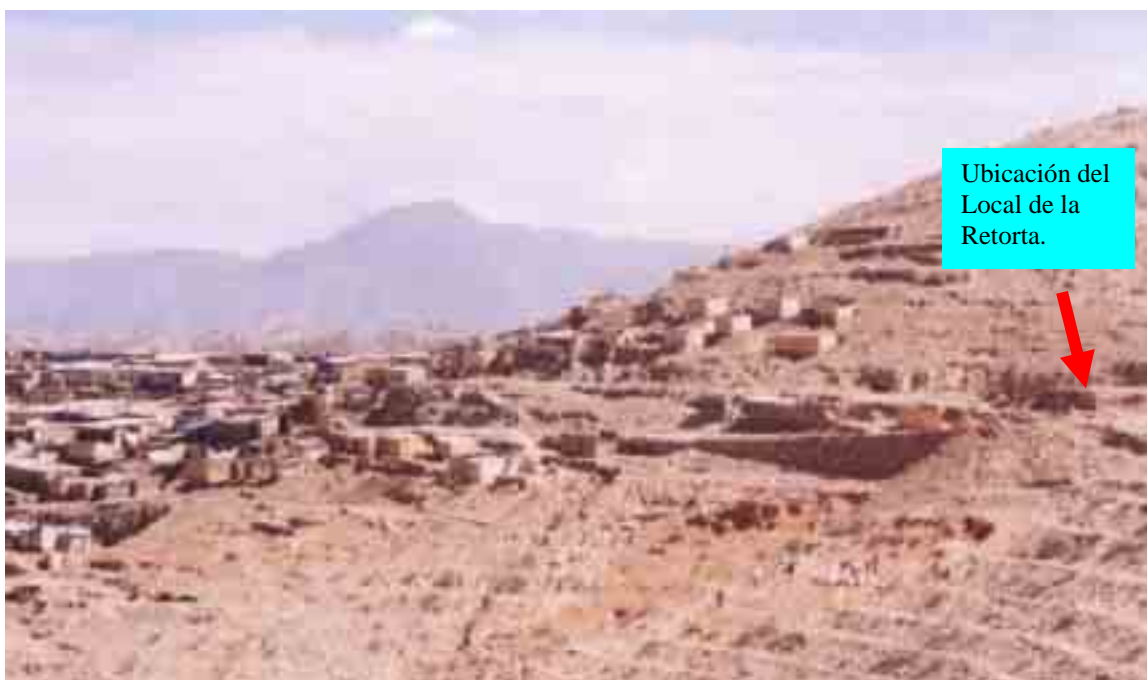
Foto 1: Vista panorámica de la población y ubicación del local de la retorta comunal.
