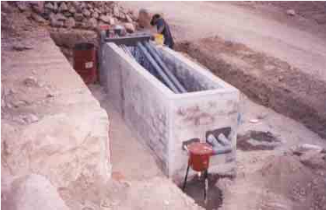
Foto 12: Reparación de tuberías de la retorta comunal.
