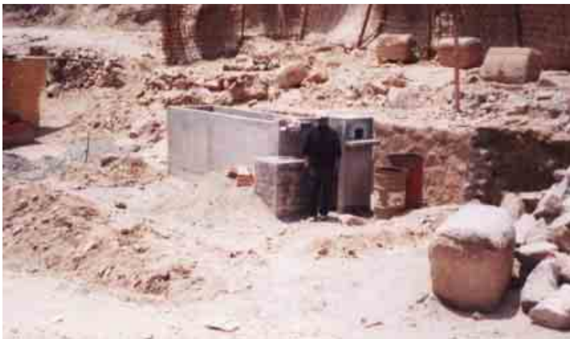
Foto 9: Retorta concluida, esperando la construcción del local, para protección y para proseguir con la instalación de los tubos y accesorios.
