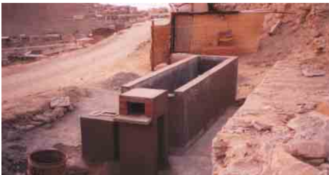
Foto 6: Culminación de la construcción de la retorta comunal
