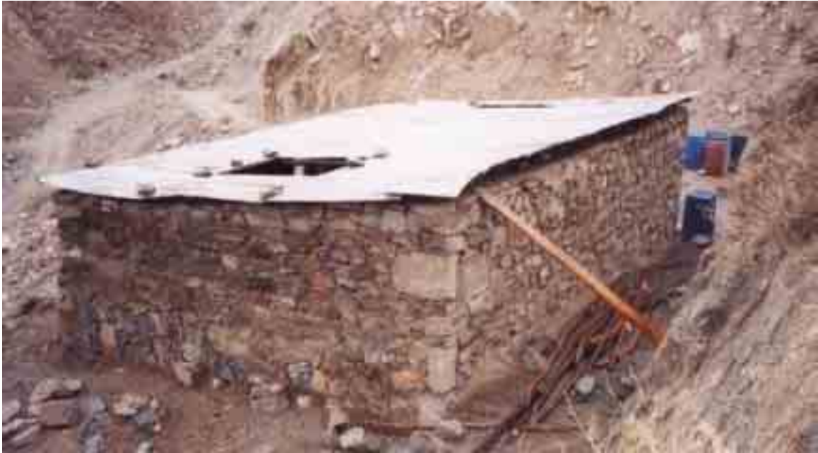
Foto9: Vista posterior del Local de la retorta terminado.
