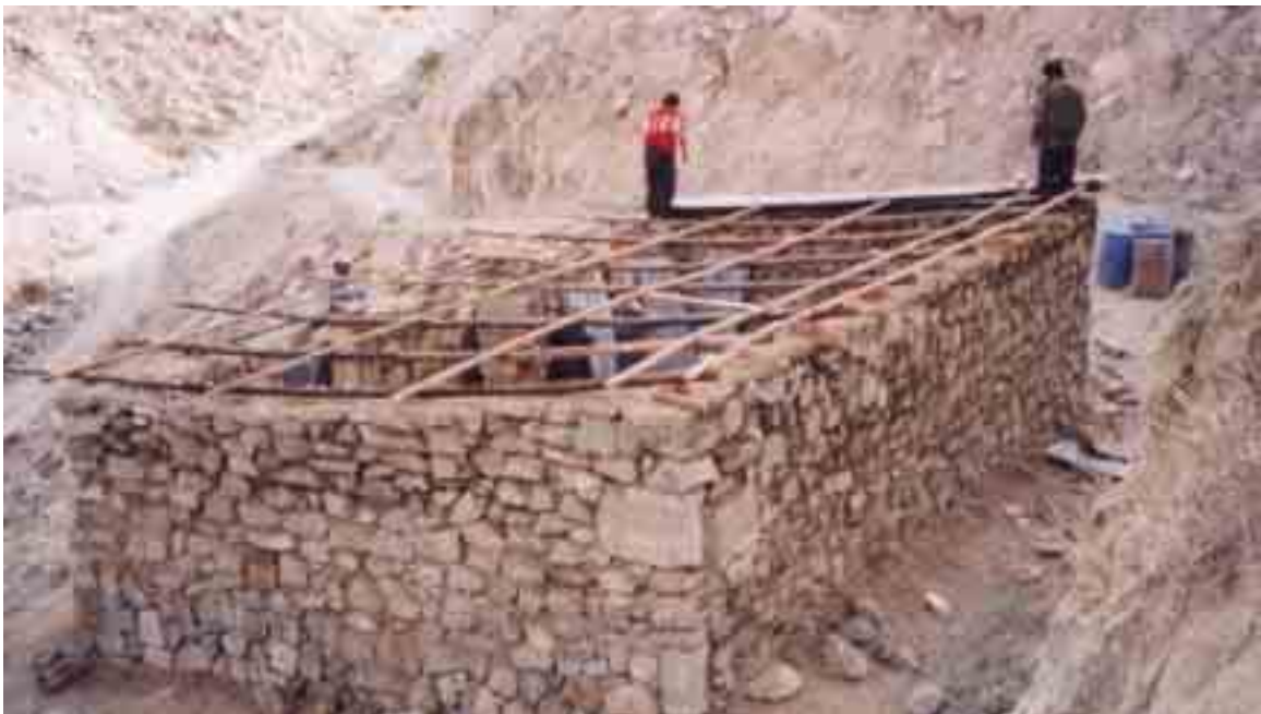
Foto8: Construcción y techado del local de la retorta
