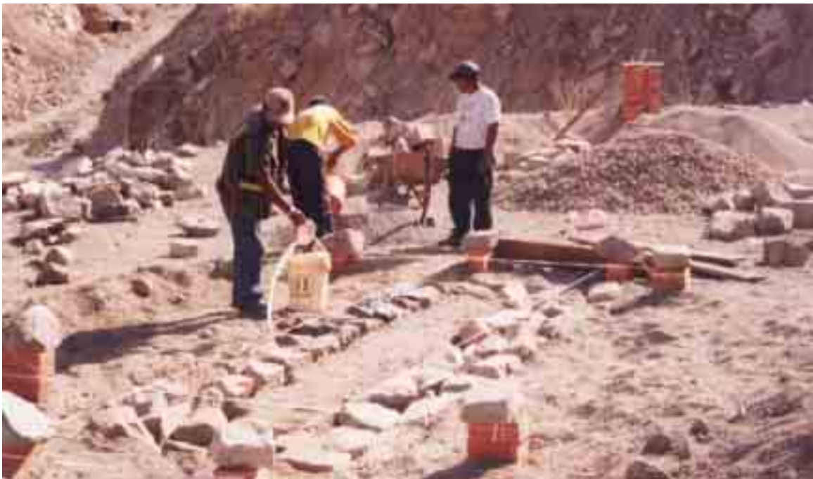
Foto3: Inicio de la construcción de la retorta comunal, con la dirección técnica del Ingeniero del Grupo Consultor.
