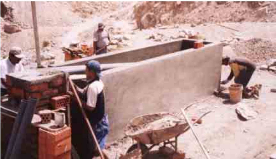
Foto 5: Culminación de los trabajos de la Retorta comunal.
